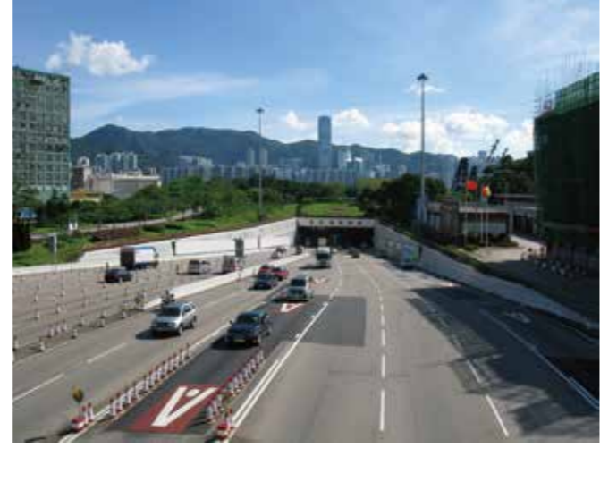
東區海底隧道
